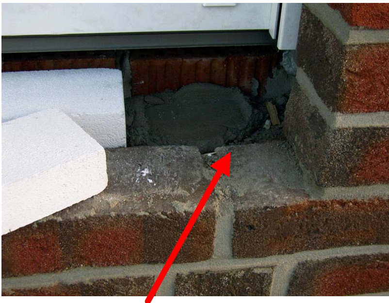
Bild 4 Stein auf Dämmung gemauert
