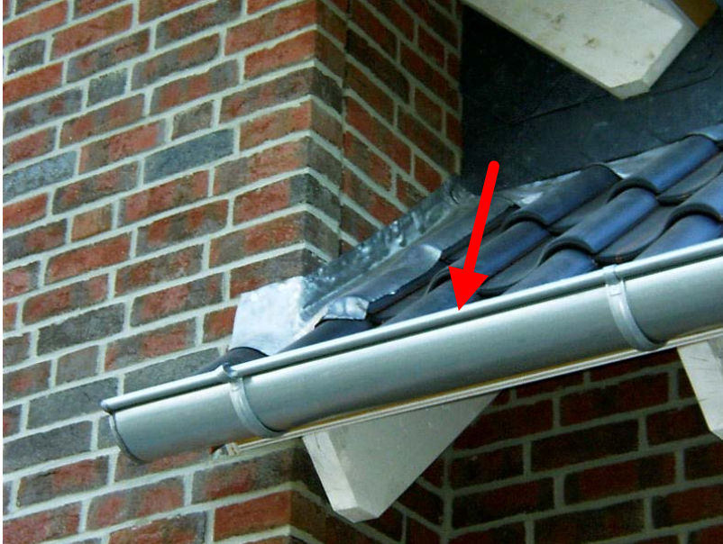
Bild 9 Hier fehlt die Kappleiste
