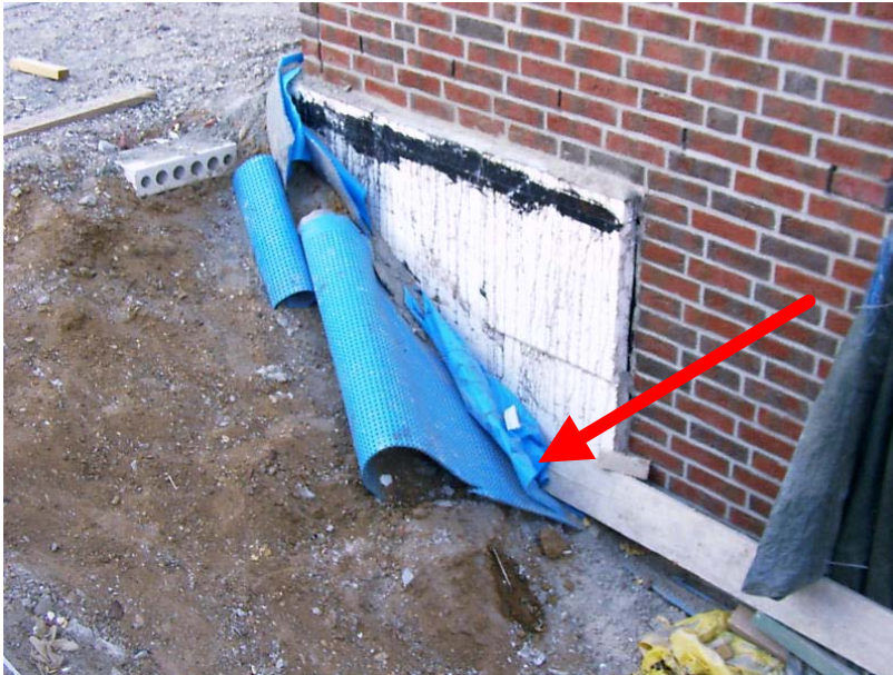
Bild 5 Dränagefolie hat sich gelöst
