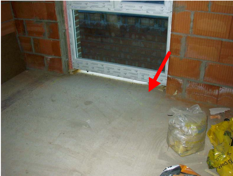
Bild 11 Fehlende unter Abdichtung
