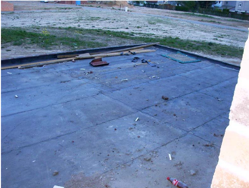
Bild 13 Die Garagendachfläche ist zu säubern
