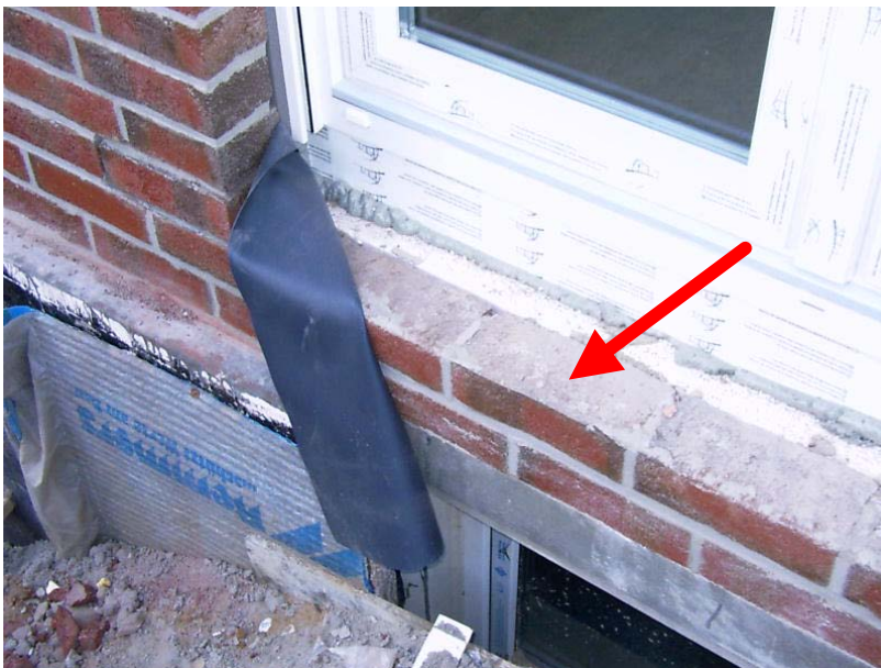
Bild 6 Äußere Fensterabdichtung fehlt noch
